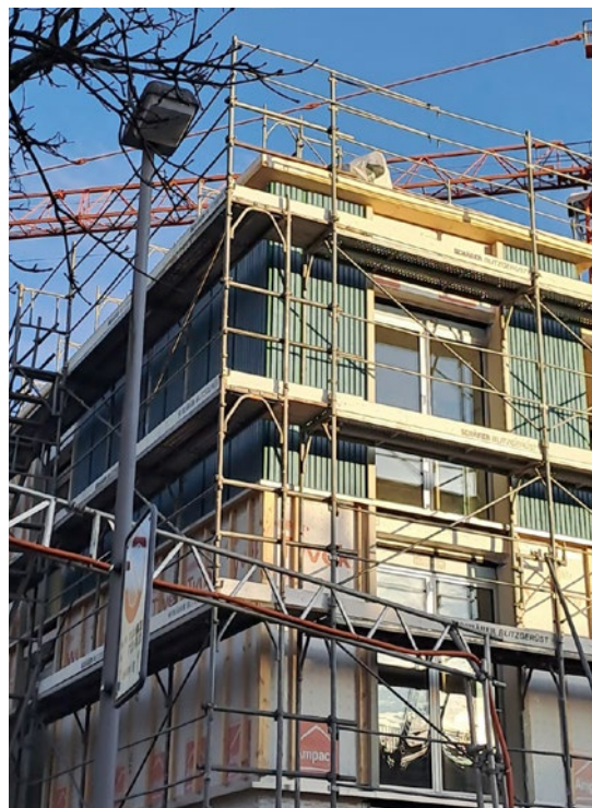
Ein gelungenes Farbkonzept: Die neue Holzfassade in blau/grün.
