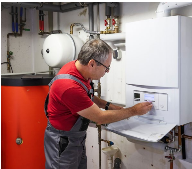
Betriebsoptimierung: In einem ersten Schritt setzen Techniker Sofortmassnahmen um.
