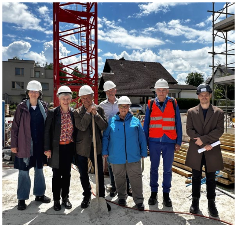
Augenschein vor Ort: Daniela Jerusalem, Sylvia Keller, Richard Wolff, Peter Keller, Renate Salzgeber, Walter Wirz und Projektleiter Cenk Toksoy (v. l.) besichtigen die Baustelle.
