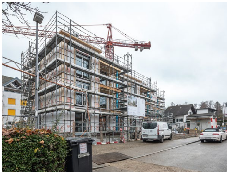
Gut gerüstet für die Zukunft: Der Neubau in Bülach.
