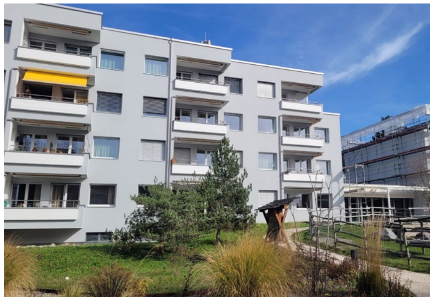
Ein cooler Look: Die Fassade zeigt sich neu in Blaugrau, einen gelungenen Akzent setzen die weissen Balkone.
