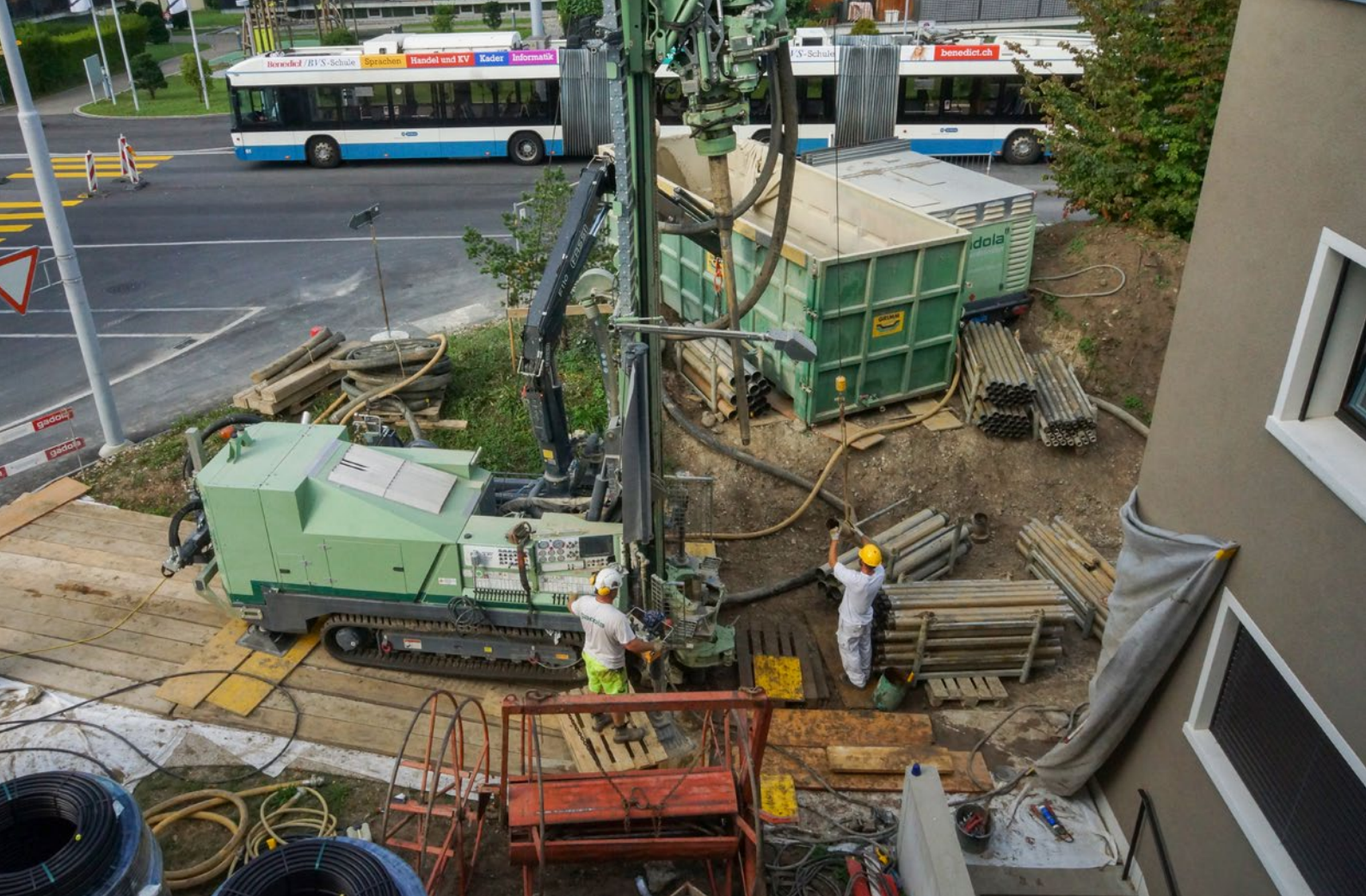
Erdsondenbohrung an der Zweiackerstrasse
